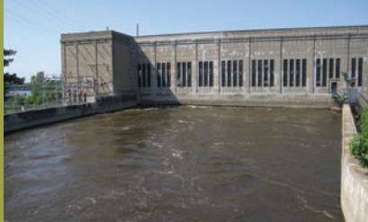
Centrale hydroélectrique de Drummondville Drummondville
