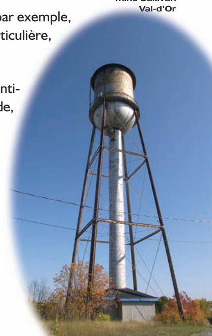
Château d'eau de l'ancienne mine Sullivan Val-d'Or
