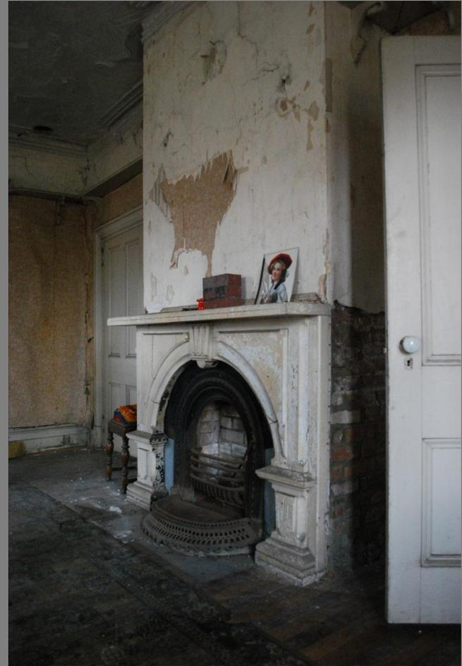
Les enduits, les plâtres, les papiers peints, les tapisseries, les cimaises et les moulures en plâtre de ces deux photographies sont endommagés et pour la plupart irrécupérables. Cependant, ils doivent être documentés. Une charte des finis et des couleurs doit alors être proposée au carnet de santé. Recréer les décors ou simplement fixer l'évolution d'un bâtiment passent inévitablement par une documentation adéquate.
