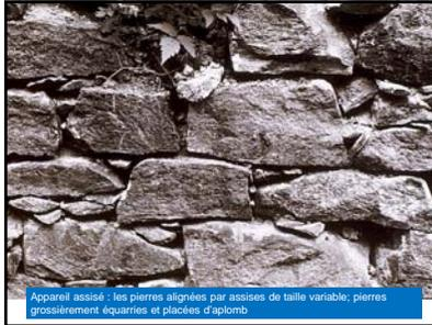
**Appareil assisé:** les pierres alignées par assises de taille variable, pierres grossièrement équarries et placées d'aplomb
