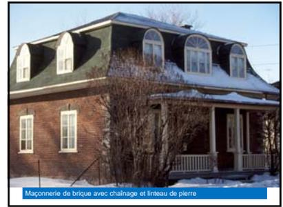
Maçonnerie de brique avec chaînage et linteau de pierre
