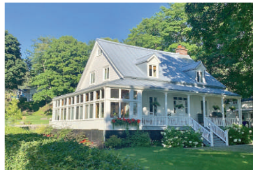
Villégiature, galerie, toiture de tôle à baguettes, symétrie et carré
