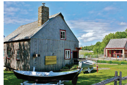
Bardeaux, joyau patrimonial, exemple d'adaptation d'usages, exemple de transformation pour la grange de l'entrée de l'île
