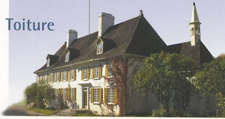
Toit à quatre versants à forte pente
