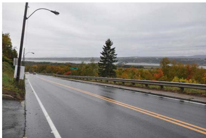
Tronçon 22 Côte du pont direction nord
