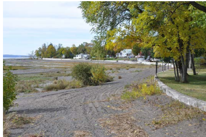
Tronçon 7 Mur et accès au ruisseau
