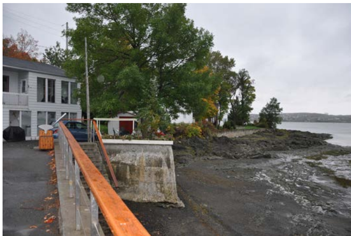
Tronçon 24 Accès au rive
