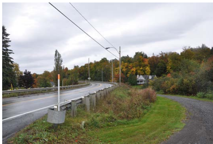
Tronçon 22 Côte du pont direction sud
