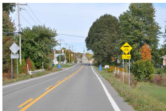
Tronçon 10 Entrée du village de Saint-François
