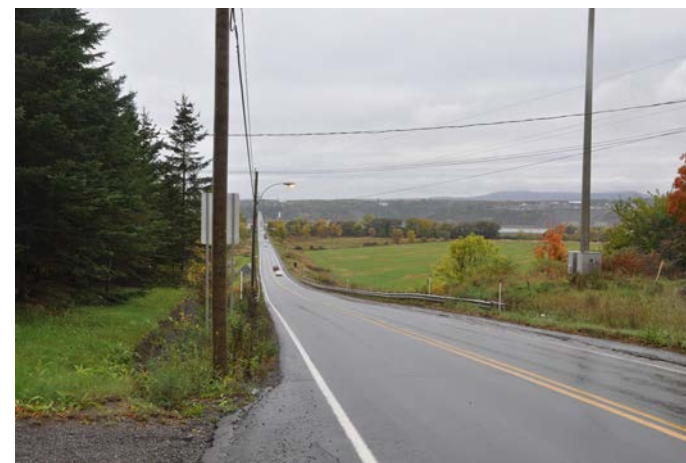
Tronçon 22 Sortie de l'île
