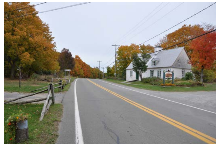
Tronçon 15 Maison Drouin
