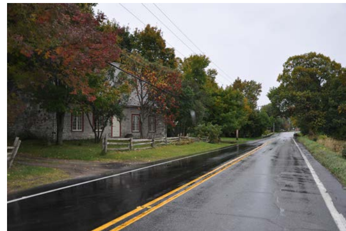
Tronçon 17 Chemin Royal et immeuble classé
