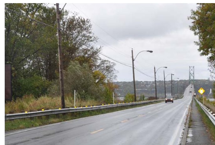
Tronçon 22 Sortie de l'île
