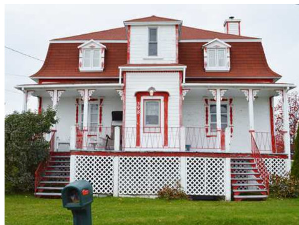
Maison à mansarde à 4 versants avec tourelle centrale sise au 398, chemin Royal à Saint-François.
