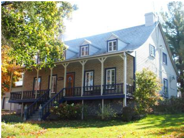
Maison traditionnelle québécoise caractérisée par sa façade principale en brique et sa balustrade en fonte située au 3994, chemin Royal à Sainte-Famille.
