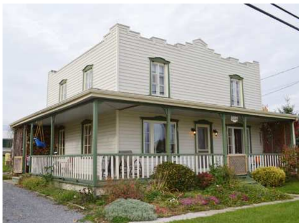
Résidence caractéristique des maisons Boomtown avec son parapet en gradins sise au 504, chemin Royal à Saint-François.
