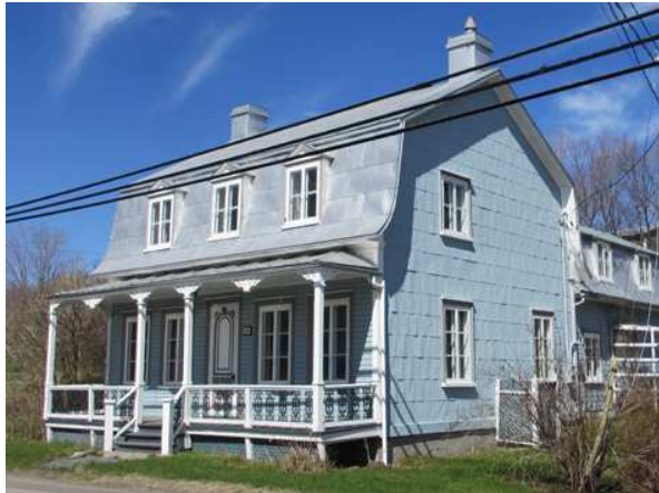
Exemple typique de la maison à mansarde à 2 versants situé au 1404, chemin Royal à Saint-Laurent.
