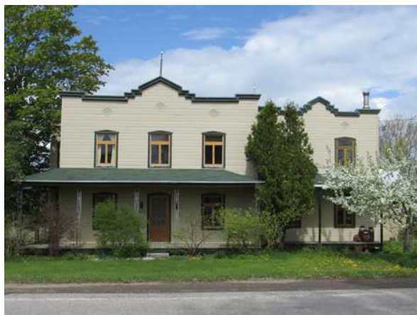
Maison Boomtown se démarquant par son imposant parapet sise au 3717, chemin Royal à Sainte-Famille. L'annexe latérale est un ajout récent.
