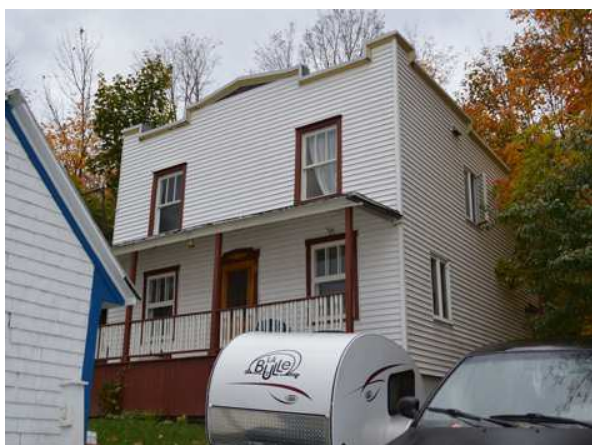
Résidence unifamiliale caractéristique des maisons Boomtown avec son parapet et sa galerie en façade sise au 1913, chemin Royal à Saint-François.
