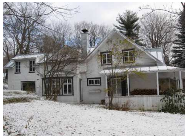
Les annexes arrière de cette maison située au 228, chemin du Bout-de-l'île à Sainte-Pétronille sont d'esprit Arts & Crafts.
