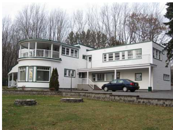
La maison Paul-Brunet située au 37, chemin de l'Église témoigne de l'architecture moderne. Son architecture s'inspire notamment d'un paquebot.
