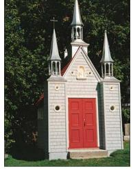
tement des murs en bardeaux d'asphalte par un revêtement de bardeaux de cèdre. Les ouvertures, les corniches et les éléments d'ornementation endommagés ont été réparés.
